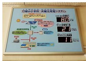
上の数字が、その時の瞬間の発電電力 (KW キロワット)
