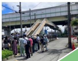
府道11号(空港線)を横断する歩道橋
