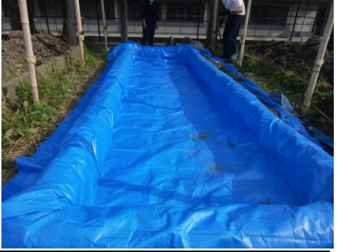
④5月25日 新しいブルーシートをして…底を補強
